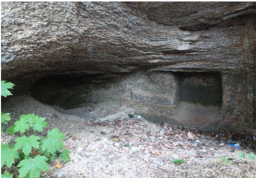
Jedna z dutin s nestabilním stropem. Bude vyzděna na sucho a zaplombována.
