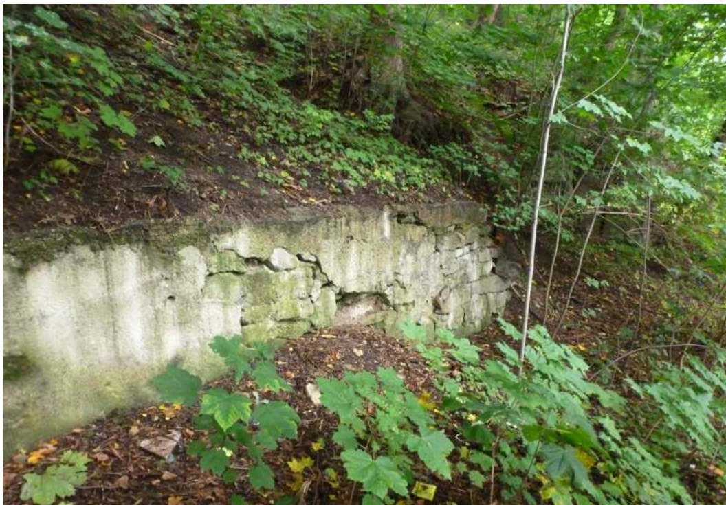
Nefunkční zídka v severní části staveniště. Bude vyzděna z dovezeného kamene.
