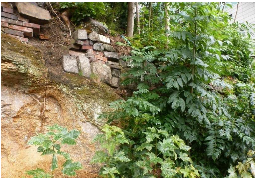
Stávající, nestabilní zídky budou ručně rozebrány a některé nově vyzdeny.
