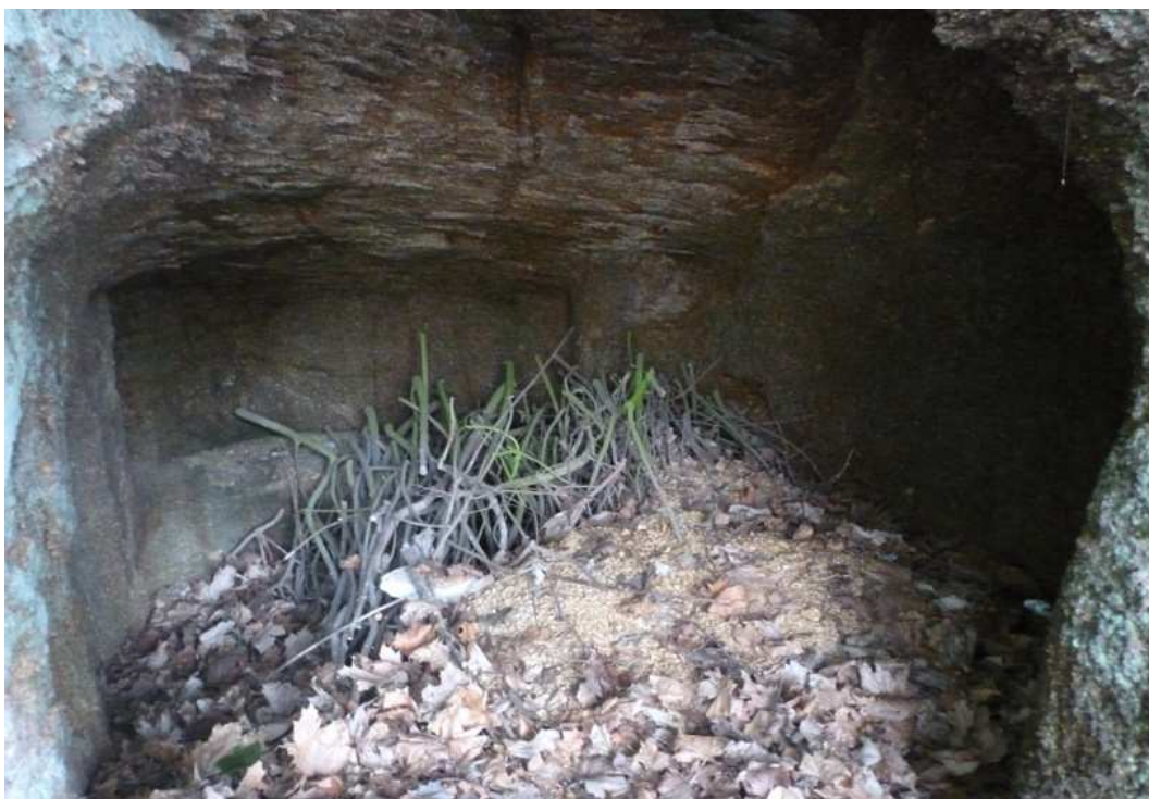
Dutina se stabilním stropem. Bude vypilířována a vstup bude zaplombován.
